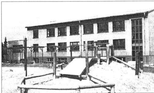
Dieses Gebäude, in dem unter anderem der Speisesaal und das Sekretariat der Schule untergebracht sind, wird saniert.
