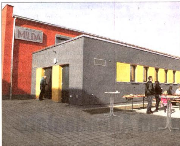
In leuchtenden Farben präsentiert sich die Turnhalle. Sie wurde komplett neu errichtet. Stehen blieb nur der Sanitärtrakt. Er wurde aufwändig saniert.
